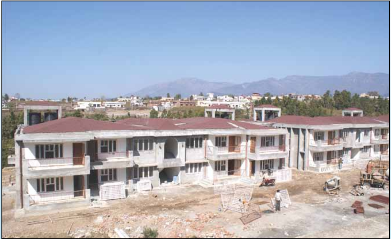
निर्माणाधीन आवासीय भवन, कौलागढ़
