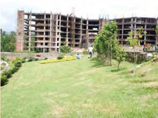
निर्माणाधीन कार्यालय भवन, कौलागढ़।
