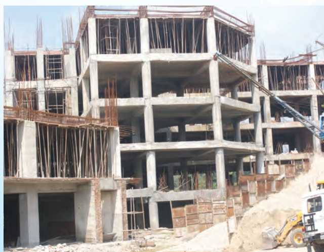
निर्माणाधीन कार्यालय भवन, कौलागढ़, देहरादून
