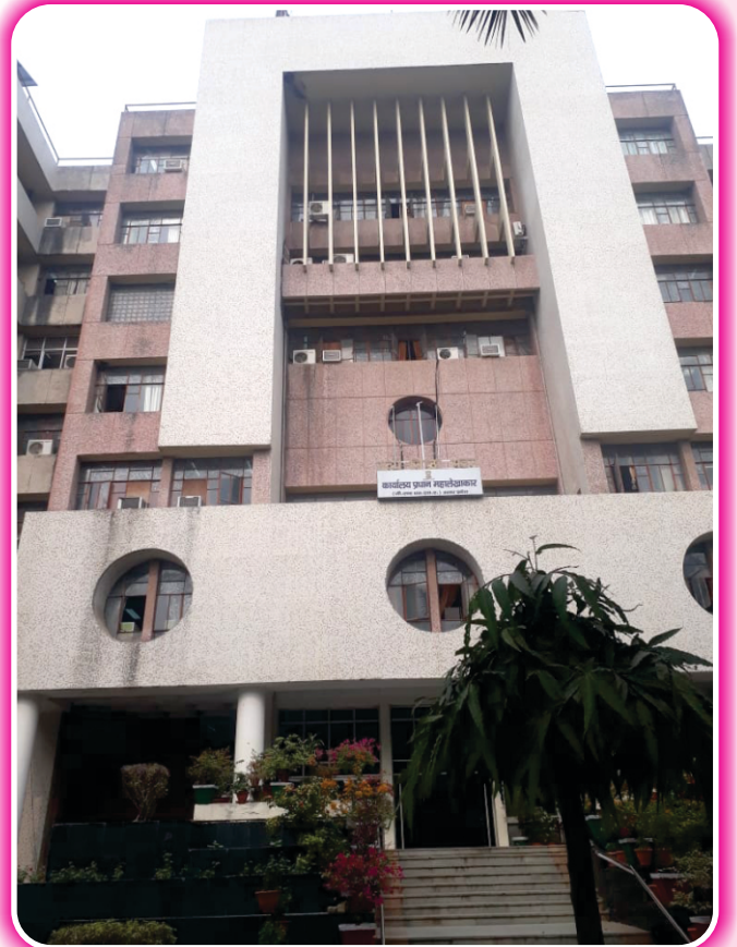
सत्यनिष्ठा भवन कार्यालय प्रधान महालेखाकार, प्रयागराज
