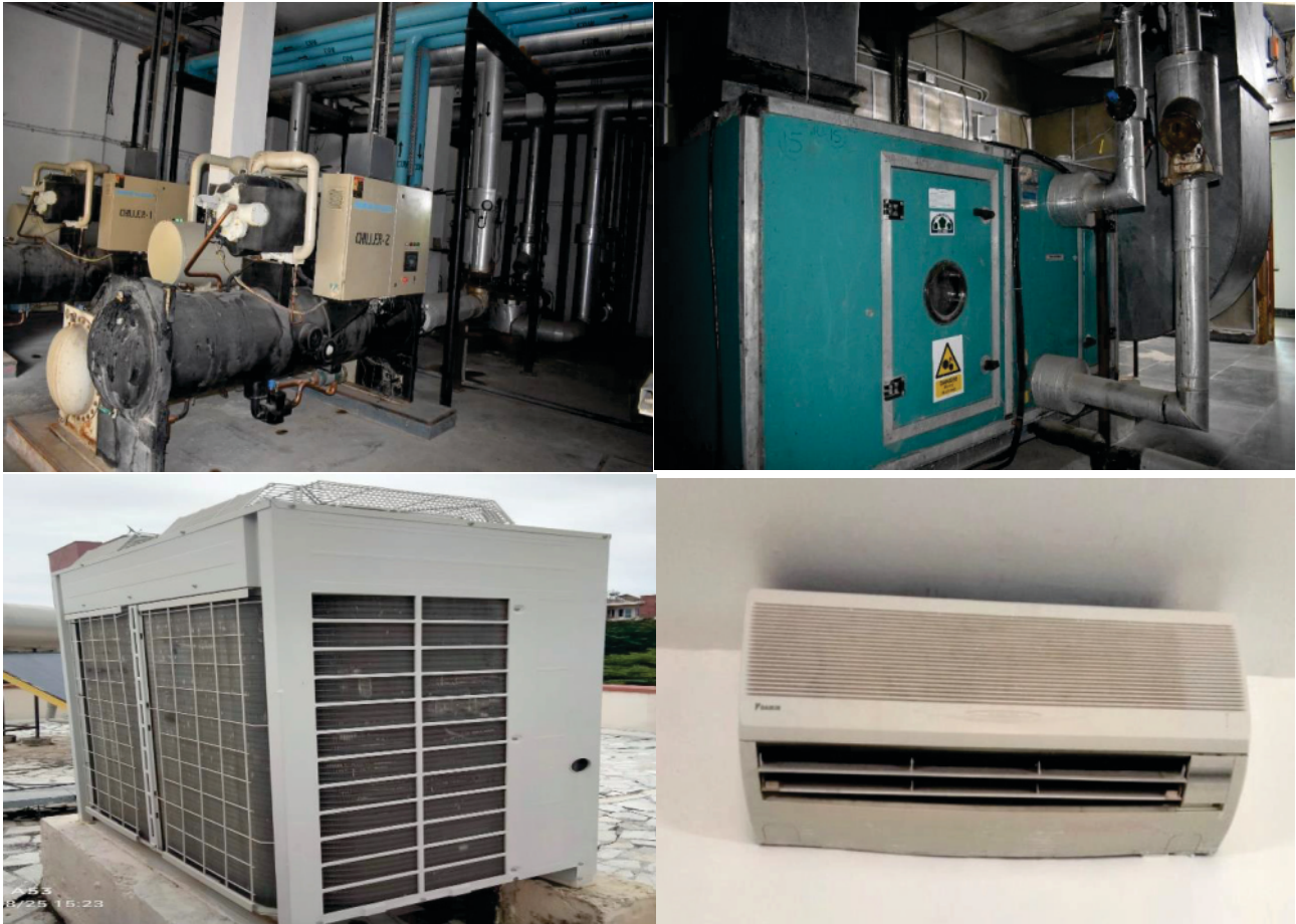
चित्र 4, 5 एवं 6 : स्कू चिलर, वेरिएबल रेफ्रिजरेंट वॉल्यूम यूनिट, वेरिएबल एयर वॉल्यूम एयर हैंडलिंग यूनिट (एएचयू)
