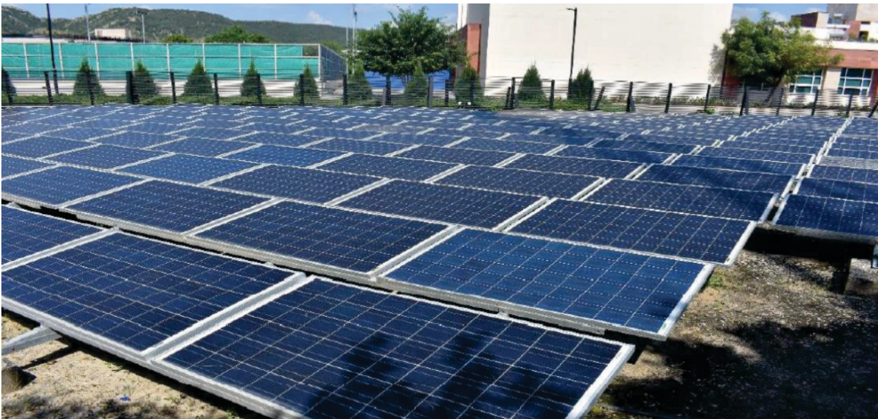
चित्र 9 : 50 किलो वोल्ट क्षमता का सौर उर्जा सयंत्र
