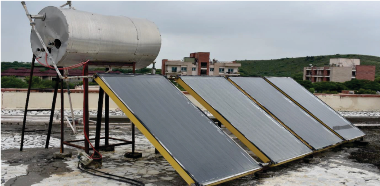
चित्र 8 : इमारतों में गर्म पानी के लिए सौर जल तापन प्रणाली का उपयोग किया गया है
