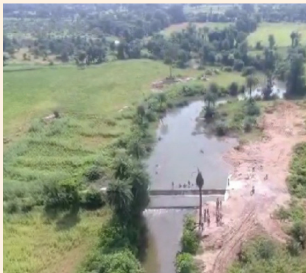
चेक डैम निर्माण ग्राम पंचायत नन्दगायकलां अच्छट संकुल जिला छत्तरपुर
