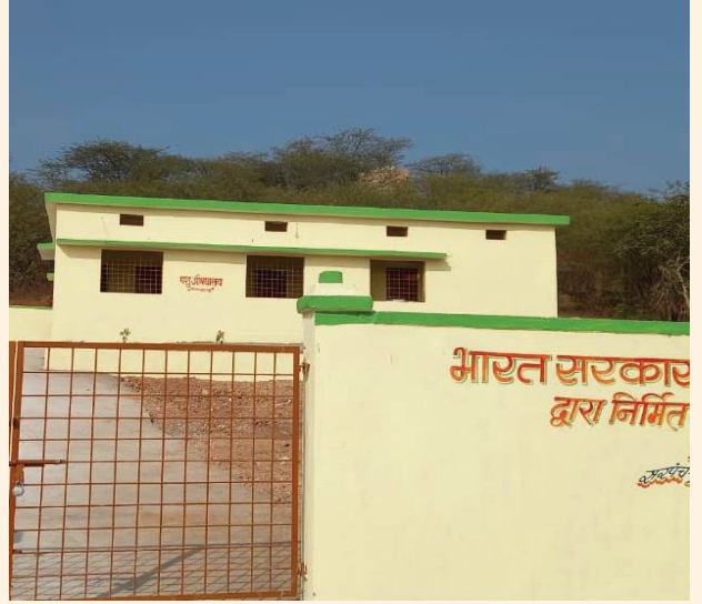
पशु औषधालय निर्माण छीमक संकुल जिला ग्वालियर
