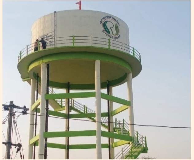
जलापूर्ति हेतु टंकी निर्माण गुनावद संकुल जिला धार
