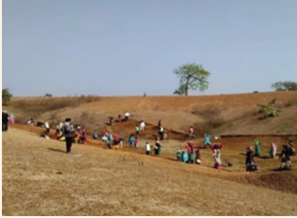
तालाब निर्माण कार्य, ग्राम पंचायत पत्थरपाड़ा, जनपद पंचायत भीकनगांव, जिला खरगौन
