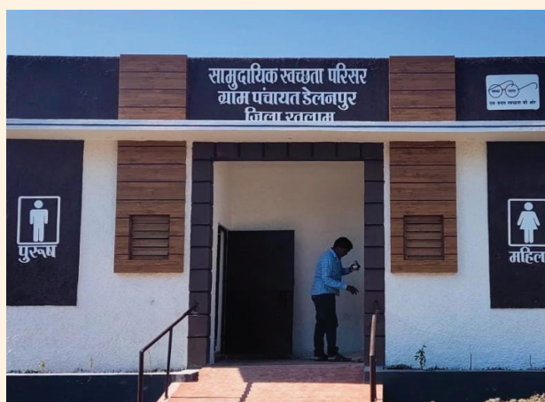
ग्रामीणों की सुविधा हेतु सामुदायिक स्वच्छता परिसर का निर्माण, जिला रतलाम
