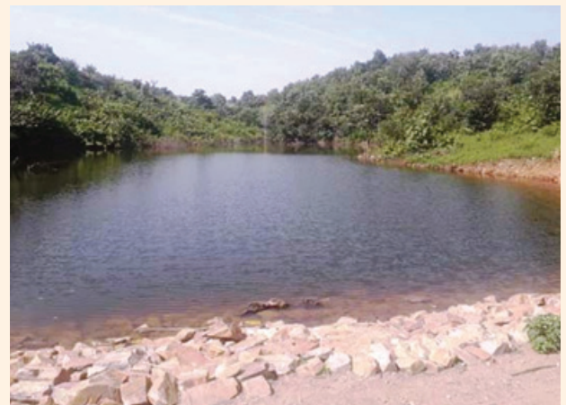
पर्कोलेशन निर्माण कार्य, ग्राम पंचायत जवानिया, जनपद पंचायत भाभरा, जिला अलीराजपुर
