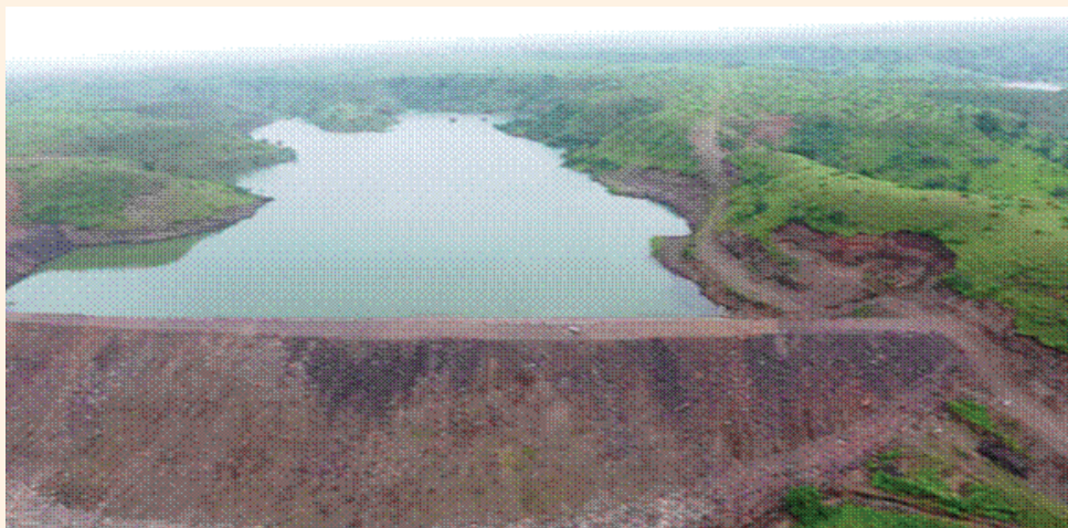
सरोवर निर्माण तनाजा जिला धार लंबाई — 230 मीटर, हाईट — 26.20 मीटर, सिंचाई क्षमता 85 हेक्टेयर व्यय रु. 210.54 लाख
