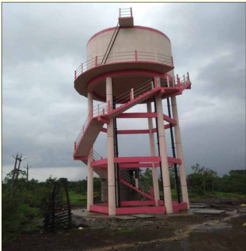
टंकी निर्माण ,कलारा ग्राम पंचायत, गुनगा संकुल जिला भोपाल
