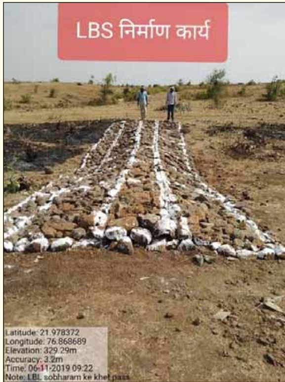
नदी पुनर्जीवन कार्यक्रम अंतर्गत लूज बोल्टर, गेबियन स्ट्रक्चर, कन्टूर ट्रेंच निर्माण कार्य जिला-खण्डवा
