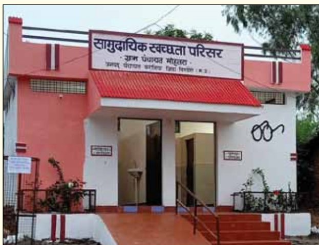
ग्रामीणों की सुविधा हेतु सामुदायिक स्वच्छता परिसर का निर्माण, जिला डिण्डोरी
