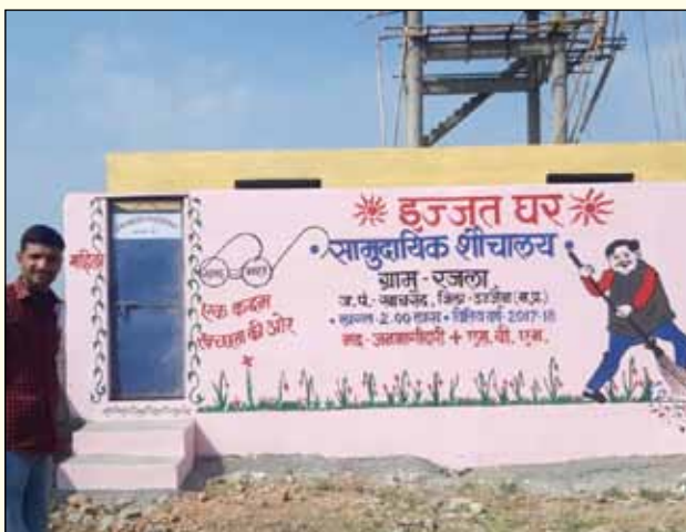
ग्रामीणों की सूविधा हेतु सामुदायिक स्वच्छता परिसर का निर्माण, जिला उज्जैन
