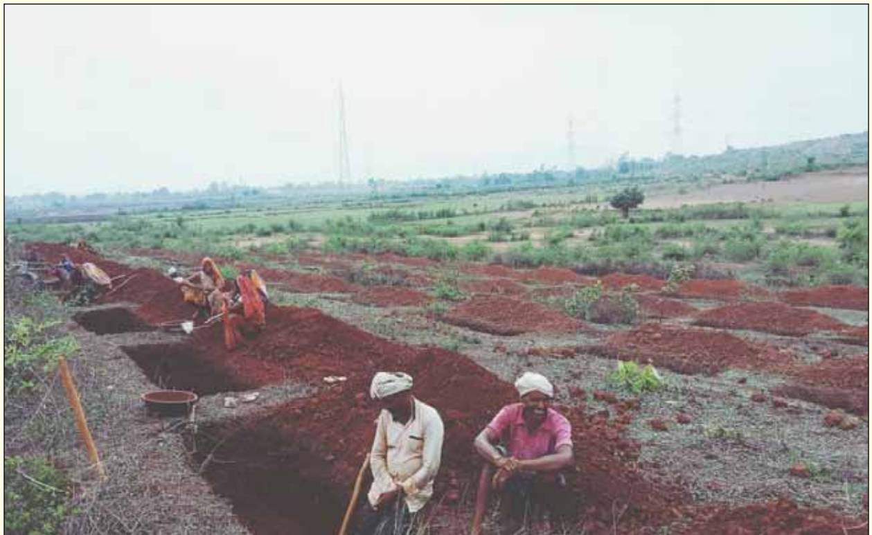
नदी पुनर्जीवन कार्यक्रम अंतर्गत लूज बोल्टर, गेबियन स्ट्रक्चर, कन्टूर ट्रेंच निर्माण कार्य जिला-खण्डवा
