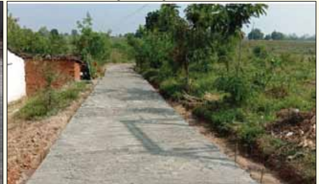
सी.सी सड़क निर्माण, कान्हीवाड़ा संकुल जिला सिवनी
