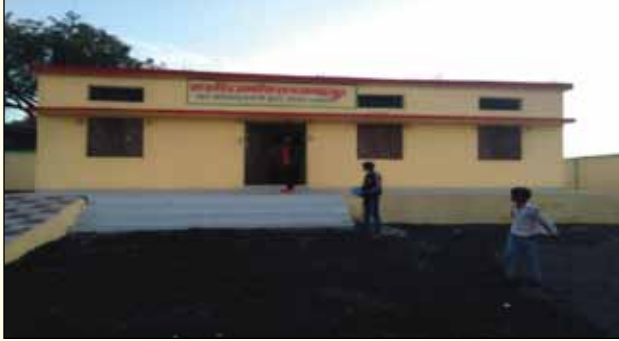
नवीन प्राथमिक शाला निर्माण, गुनगा संकुल, जिला भोपाल
