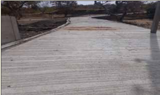
सी.सी सड़क निर्माण, सिमरोल संकुल, जिला – इंदौर
