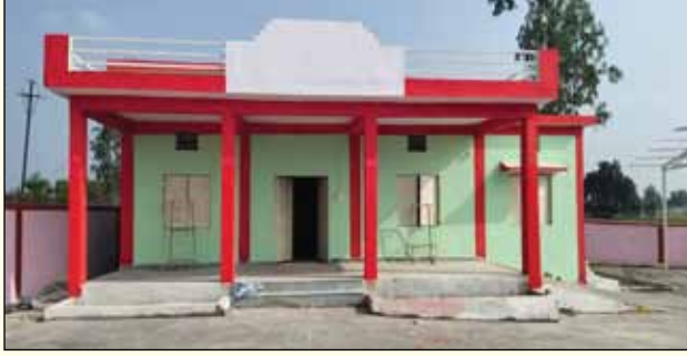
सामुदायिक भवन निर्माण, बड़झिरी – ग्राम पंचायत, रातीबड़ संकुल, जिला – भोपाल
