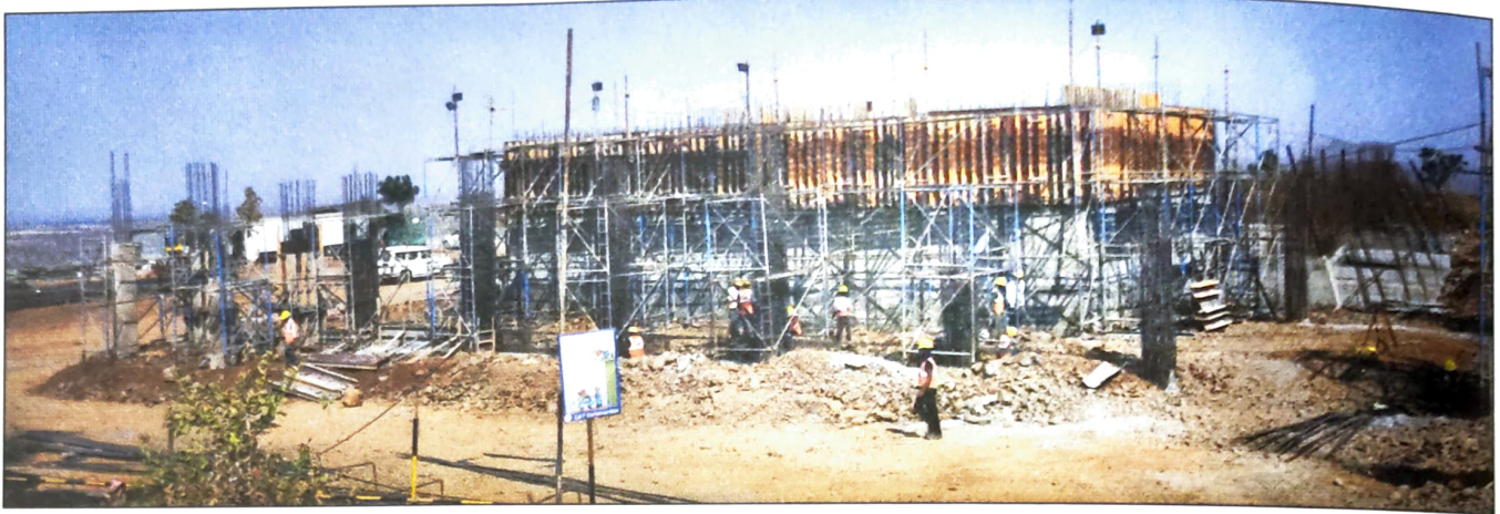
खण्डवा जिले में छैगांवमाखन माइक्रो सिंचाई योजना का निर्माणाधीन पम्प हाउस क्र. 2
