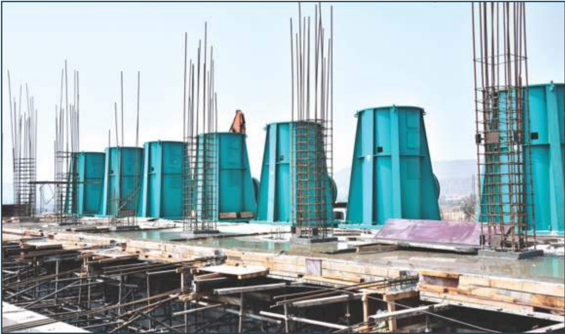
नर्मदा मालवा गंभीर लिंक योजना का निर्माणाधीन पम्पिंग स्टेशन।
