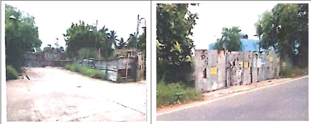
চিত্র 4.26: পুরানো টিনের পাত এবং বাঁশ দিয়ে তৈরি প্রেক্ষাগৃহের অস্থায়ী সীমানা প্রাচীর জরাজীর্ণ অবস্থায়
