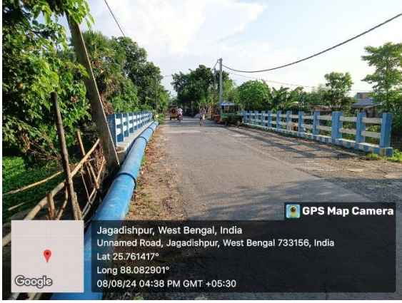
চিত্র 4.8: উত্তর দিনাজপুর মহাসড়ক ডিভিশন পি ডব্লিউ ডি (সড়ক)-এর মোকদমপুর-ভাটোল রোডের 1.00 কিমিতে সেতুর প্রধানকাঠামোর উপর পাইপ লাইন স্থাপন করা হয়েছে
