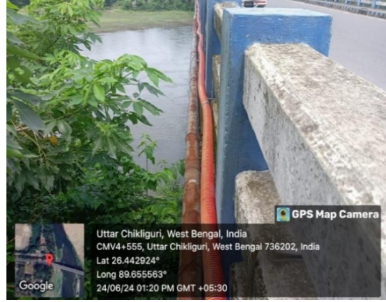
চিত্র 4.9: আলিপুর ডিভিশনের (পি ডব্লিউ ডি) আলিপুরদুয়ার-ভলকা রোডের 10.70 কিমিতে রায়ডাক সেতুর রেলিংয়ের সাথে দুটি হোসপাইপ ঝুলছে
