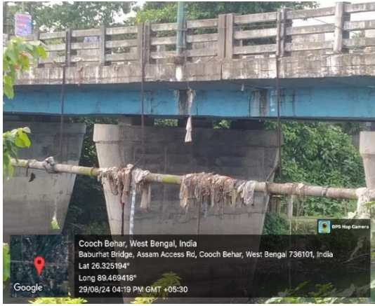
চিত্র 4.10: কোচবিহার ডিভিশনের (পি ডব্লিউ ডি) অন্তর্গত কোচবিহার দিনহাটা গিটালদহ সড়কের 2 কিমিতে মোরা তোরী সেতুর রেলিংয়ের সাথে পাইপলাইন ঝুলছে
