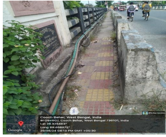
চিত্র 4.11: কোচবিহার ডিভিশনের (পি ডব্লিউ ডি) অন্তর্গত কোচবিহার দিনহাটা গিটালদহ সড়কের 2.00 কিমিতে মোরা তোরী সেতুর ফুটপাথে কেবল লাইন স্থাপন করা হয়েছে
