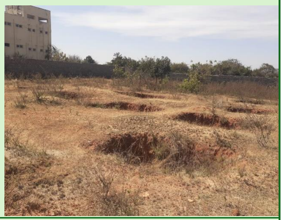
ఇండోర్ స్టేడియం: పూర్తయిన భూమి పనులు (2023 జనవరి)
