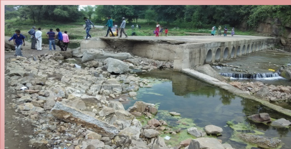
गुजरात के दाहोड जिला, में 'कामबोई पटेल फेलिया' सड़क के चेनेज 1/800 पर पानी को सुरक्षित रूप से आने जाने के लिए पाइपों के निर्माण न करने के कारण पुलिया का निर्गम भाग बह गया
